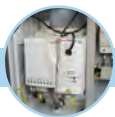
INVERTER ABB Inverter IP66 kW4 Z22 per modifica portata e velocità dell'aria
